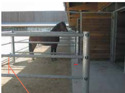
Espacement entre barreaux 42,5 cm.
