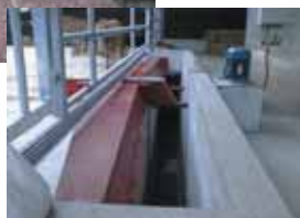
Mise en parc d'un racleur grande largeur avec système d'arrêt automatique.
