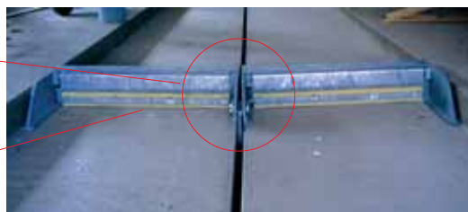
Guide central et rail de guidage
