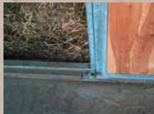
Verschlussystem der Schiebetüren
