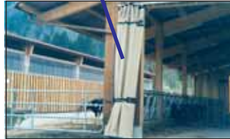
Geöffnet wird der Windschutz in sich gefaltet und wie ein Vorhang auf der Seite zusammengebunden.
